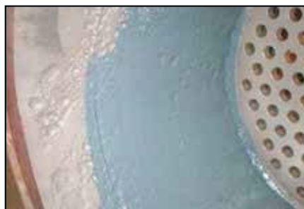
Aplikácia ARC 858, následne sa budú nanášať 2 vrstvy ARC SD4i
