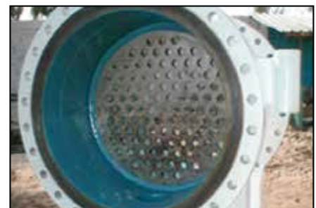
Po aplikovaní ARC SD4i, hydrocyklón dokončený
